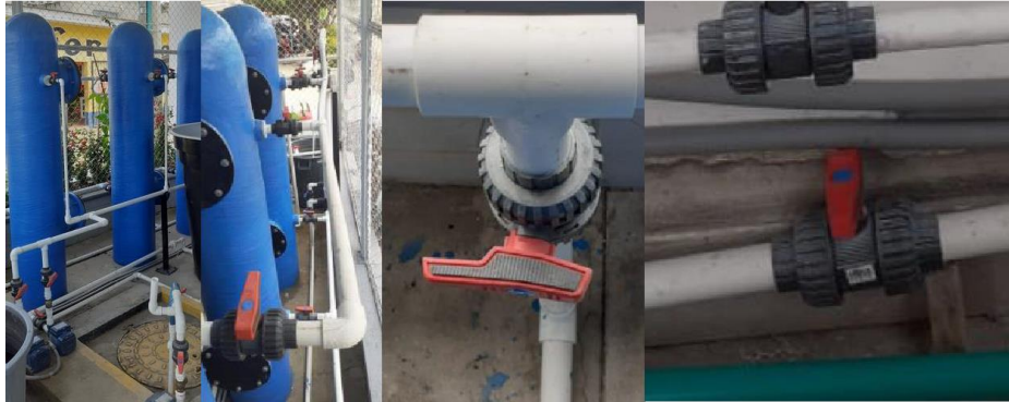
Imagen 12. Redes hidráulicas de conducción en PVC de presión de agua cruda y tratada en el proceso de tratamiento.
