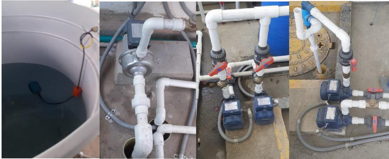
Imagen 10. Sistema de automatización con sensores de nivel tipo boya en el tanque de agua cruda y tanque pulmón para el control de encendido y apagado de las electrobombas centrífuga y peristálticas.
