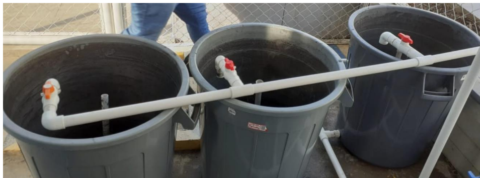
Imagen 13. Sistema de deshidratación de lodos conformado por tres módulos [Lechos de Secado].
