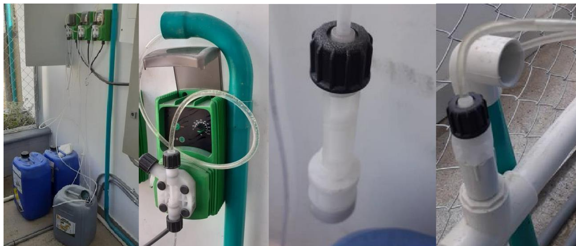
Imagen 9. Sistema de Dosificación de Peróxido de Hidrógeno con tambores, electrobombas dosificadoras, red hidráulica y válvulas de pie y de inyección.
