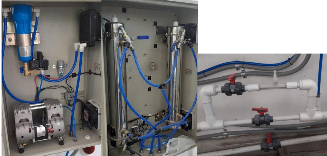
Imagen 2. Generador de Ozono conformado por un compresor, filtro de aire, sistema de refrigeración, reactor de Ozono e inyectores.
