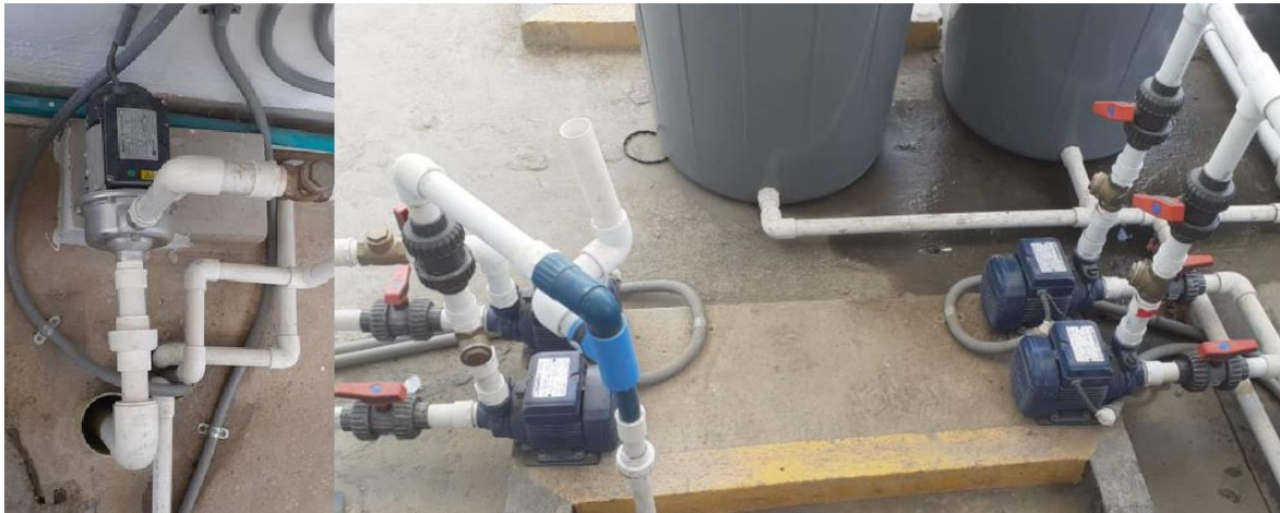
Imagen 7. Sistema de bombeo del proceso de oxidación avanzada y de filtración de la planta.
