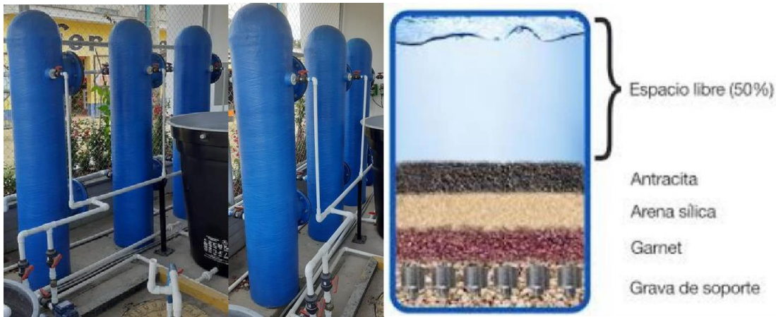
Imagen 5. Filtros de pulimento y diagrama de distribución de los lechos de filtración.
