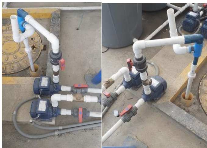
Imagen 8. Sistema de bombeo del proceso para refrigeración de los equipos de Ozono del proceso de oxidación avanzada y para Aireación y desgasificación de agua cruda del proceso primario.
