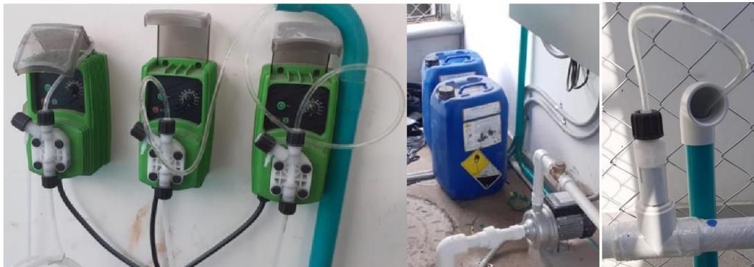
Imagen 3. Sistema de Dosificación de Peróxido de Hidrógeno conformado por electrobombas dosificadoras, tambores de solución de Peróxido de Hidrógeno e inyectores a tubería
