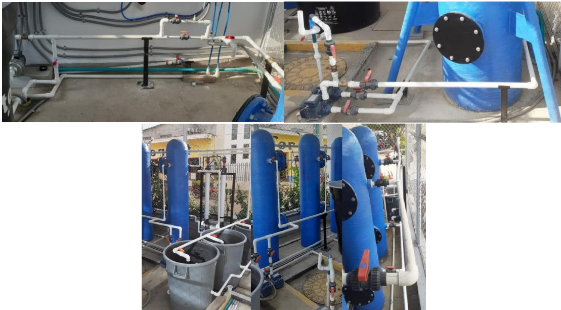
Imagen 12. Redes hidráulicas de conducción en PVC de presión de agua cruda y tratada en el proceso de tratamiento.
