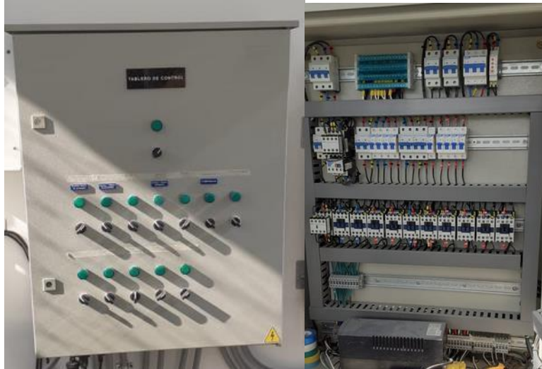
Imagen 11. Sistema de Control de operación conformado por un cuadro eléctrico.
